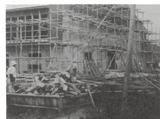
開学10周年記念体育館建設現場
